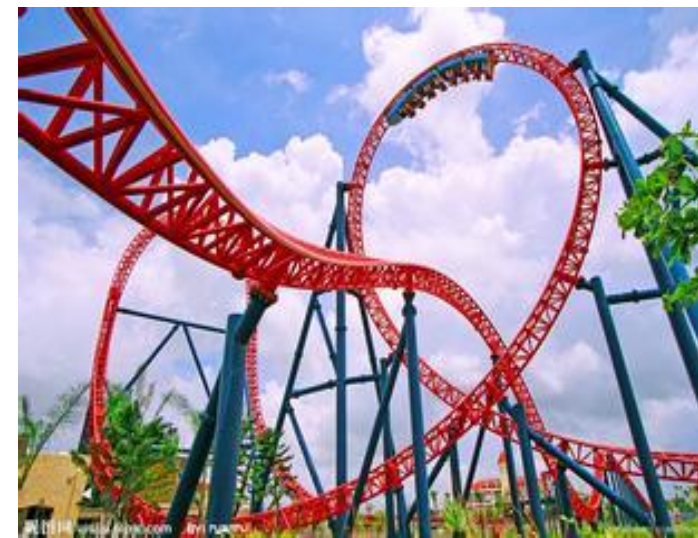
钢结构防腐涂装
