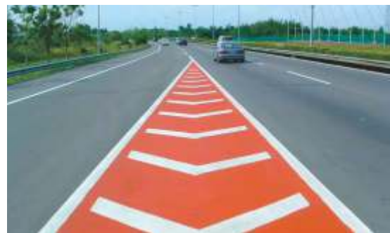
沈海高速厦门段入口匝道路标导流线
